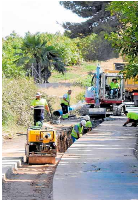
Trabajos para ejecutar la conexión, cerca del polígono. J. R. C.
