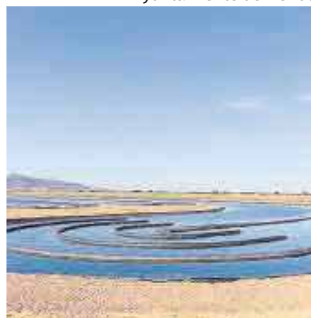
Panorámica de la planta.
